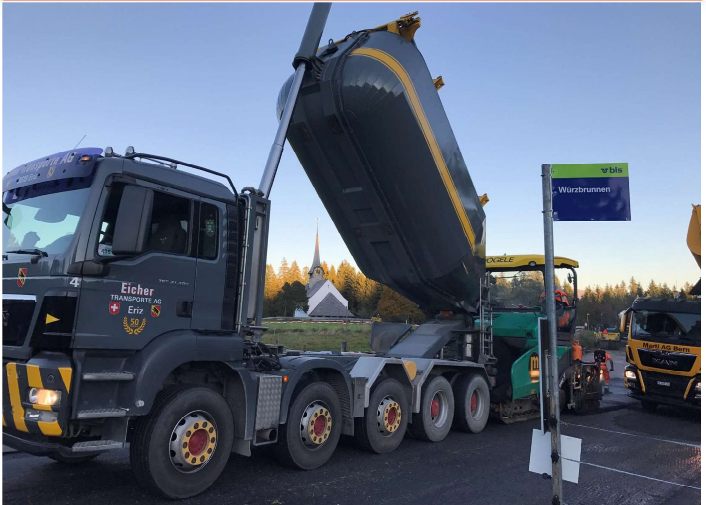
Sanierung Strasse Rötthelbach-Chuderhüsi
